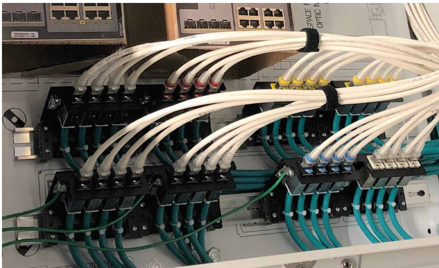
Instalaciones de carril DIN que utilizan aplicaciones PoE de soportes blindados
